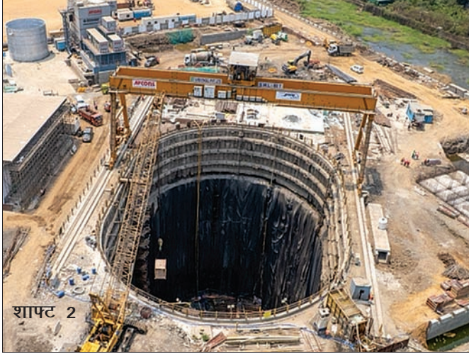
टीबीएम लॉन्चिंग के लिए कंक्रीट का काम प्रगति पर, मुंबई, महाराष्ट्र
