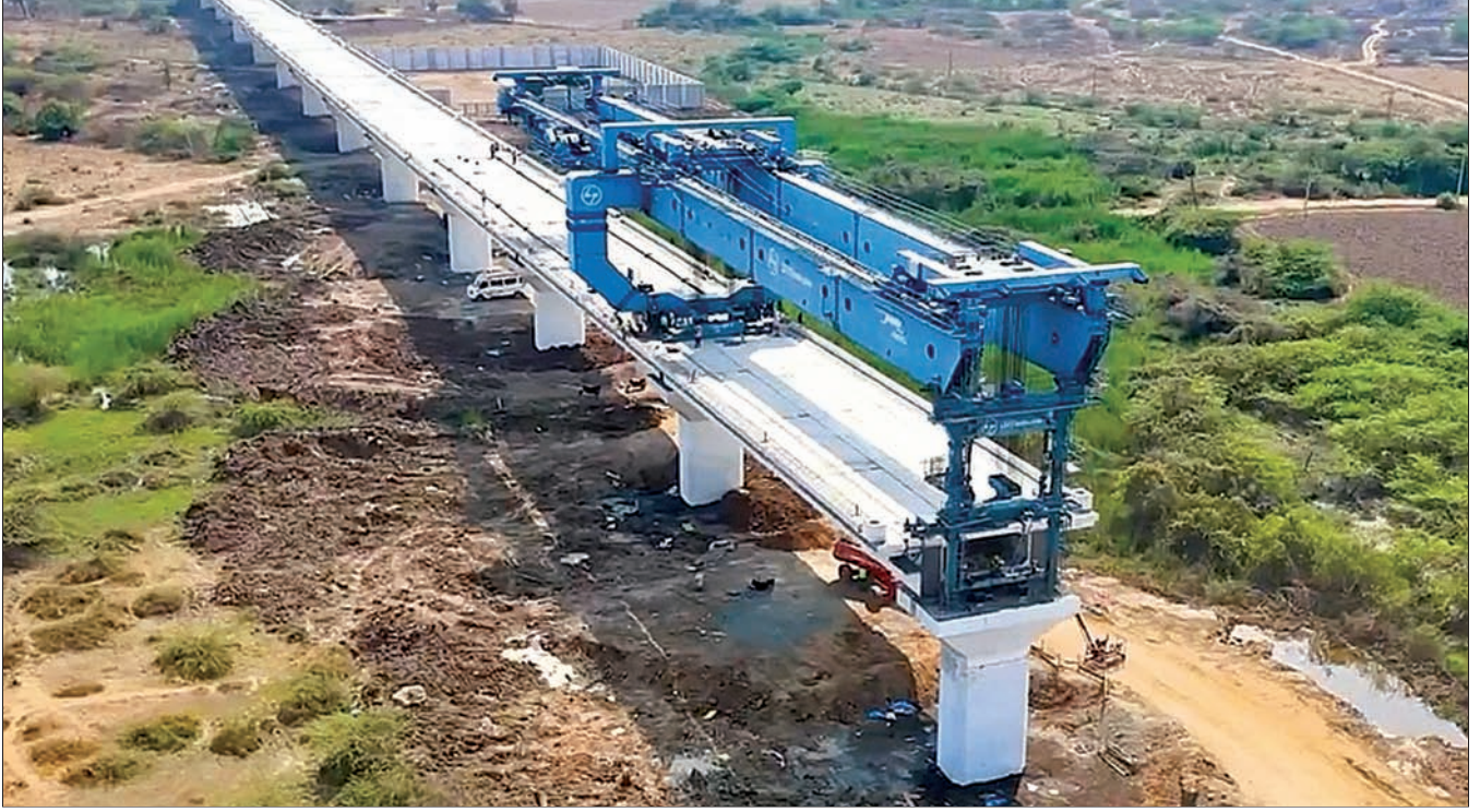
सुरत जिला, गुजरात में फुल स्पेन लॉन्विंग गैन्ट्री का उपयोग करके गर्डर लॉन्विंग का कार्य प्रगति पर
