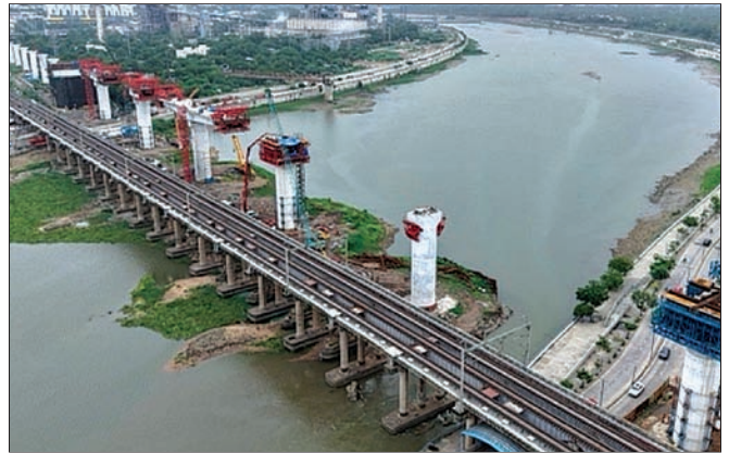
साबरमती नदी पुल, अहमदाबाद, गुजरात में प्रगति पर कार्य
