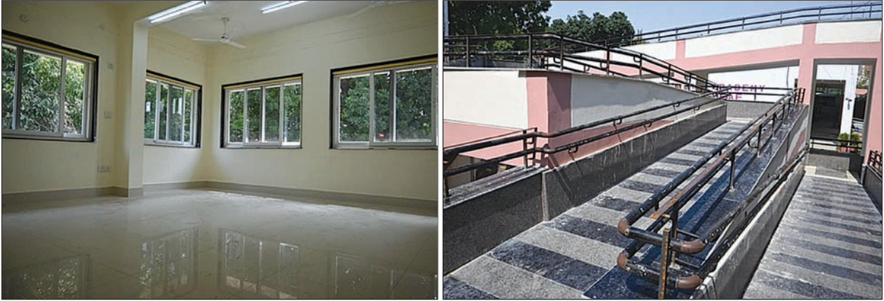
सीएसआर परियोजना – क्लासरूम और एक रैंप का निर्माण, एएडी, आईआईटी रुड़की, उत्तराखंड
