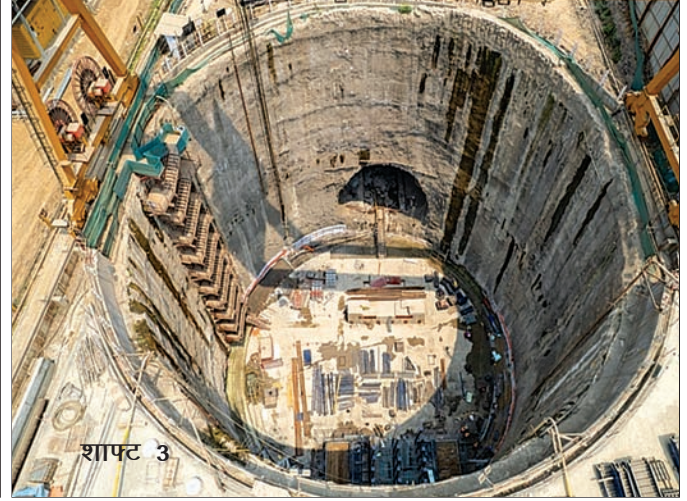
टीबीएम लॉन्चिंग के लिए कंक्रीट का काम प्रगति पर, मुंबई, महाराष्ट्र
