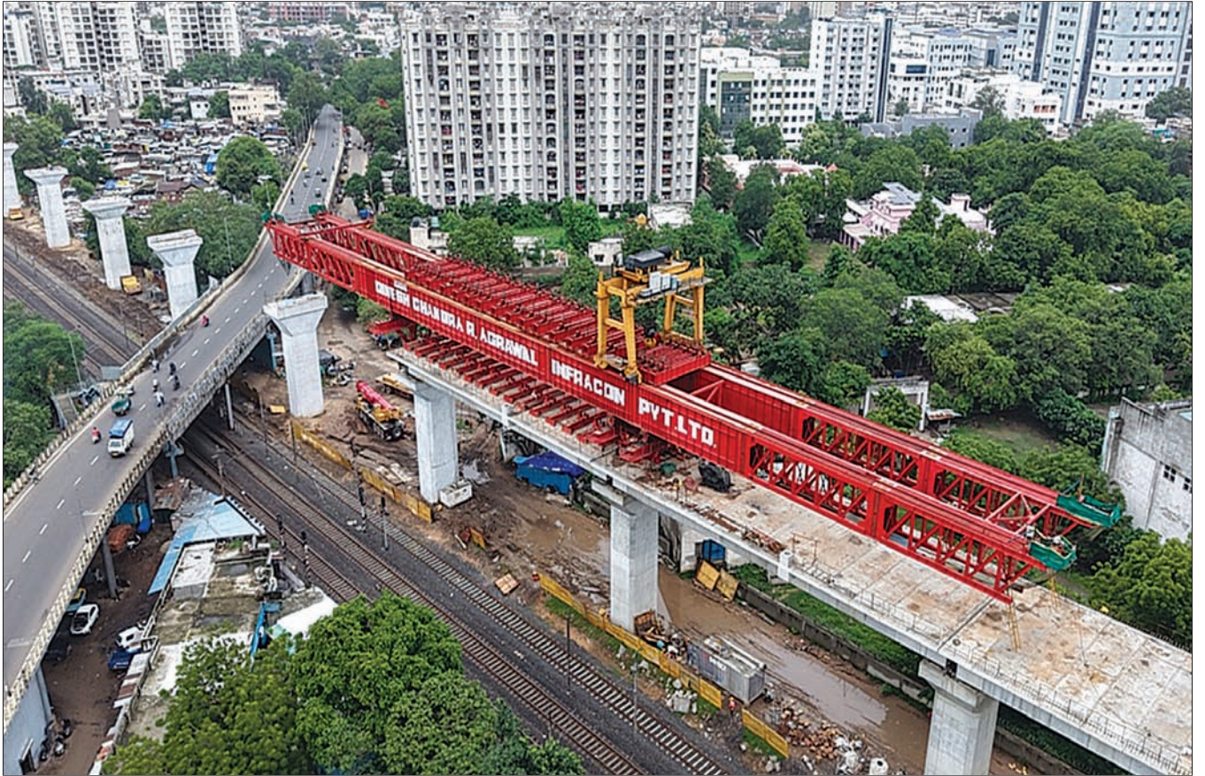
सेगमेंटल लॉन्चिंग गैन्ट्री का उपयोग करके गर्डर लॉन्चिंग प्रगति पर, अहमदाबाद जिला, गुजरात
